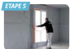
ETAPE 5 Nettoyage du chantier. Pose du double glage possible 48h après la projection.
