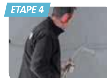
ETAPE 4 2 e passe : Projection de 2 mm environ sur chaque pan de mur (moins de 30 min après la 1 re passe).
