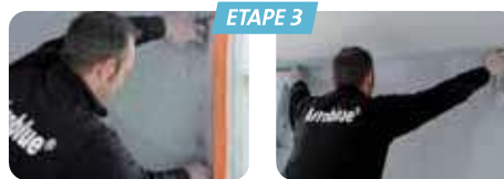
ETAPE 3 Traitement des points singuliers : Noyer la bande de fibre de verre dans le revêtement technique intérieur aux jonctions menuiseries/maçonnerie et plafond/maçonnerie.
