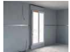
↳ Après la projection d'Aérobblue et avant la pose du double glage.
